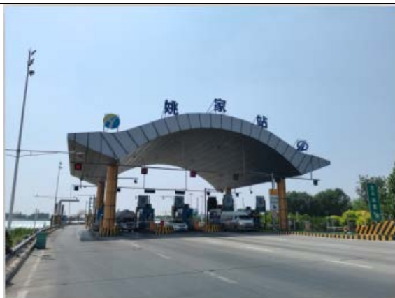
姚家收费站（本项目安装在最左侧车道）
