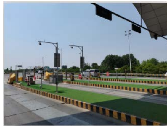
绿通车辆快检系统北侧上下站车道及树林
